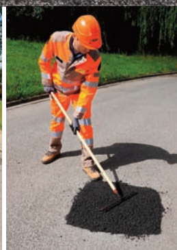
Compactage avec une dame à main ou avec une plaque vibrante.
